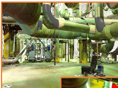
Hibridni prikaz skeniranog oblaka točaka okoline i izvlačenje postojećeg stanja i relevantnih rubova smetnji.
